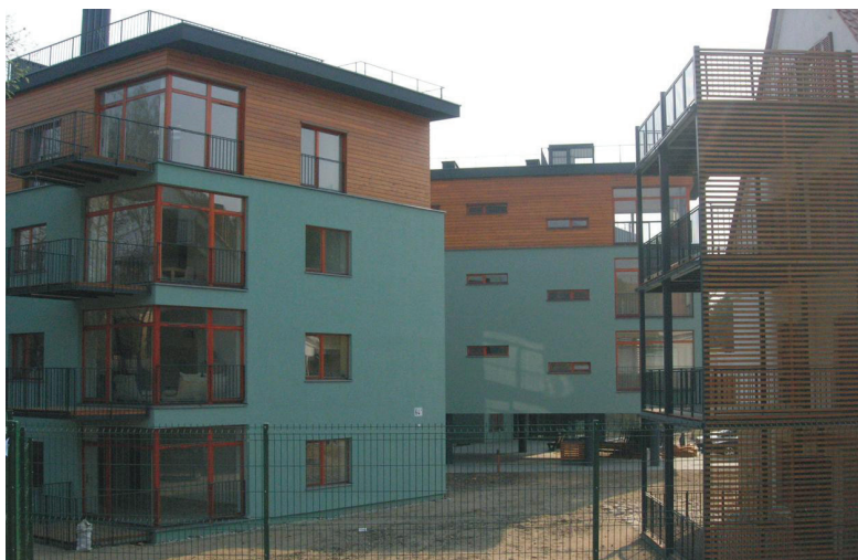
Fig. 5. Gated community in Latvių Street. 5 pav. Aptvertas kvartalas Latvių gatvėje.
